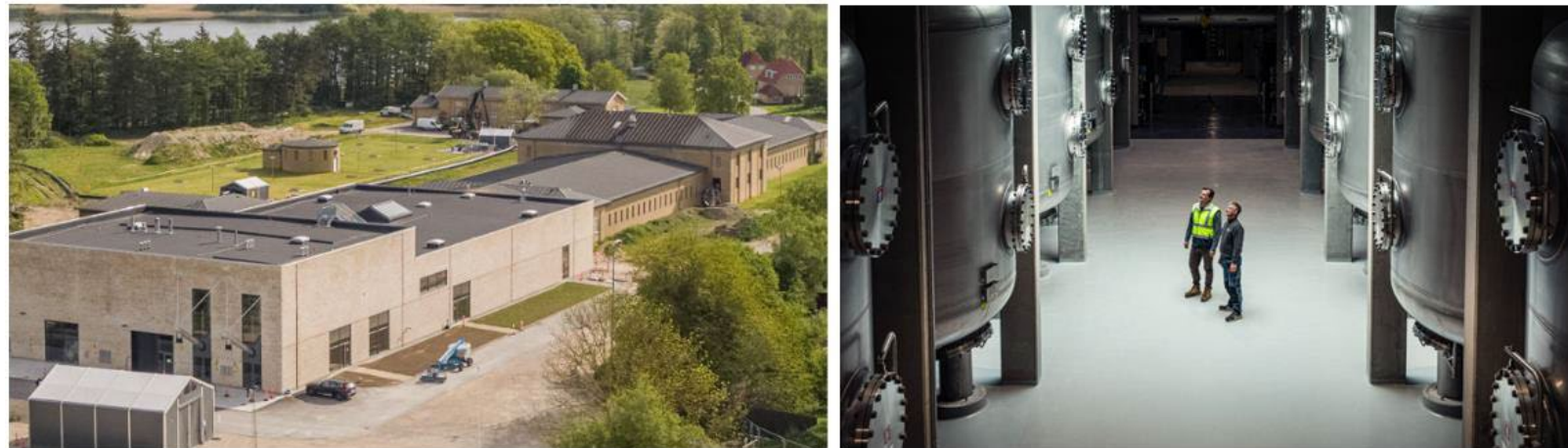
Foto af Værket ved Søndersø etape 1 samt indvendigt foto af det færdige filteranlæg. Entreprenører: NCC A/S, Wicotec-Kirkebjerg A/S og DI-Teknik A/S.
