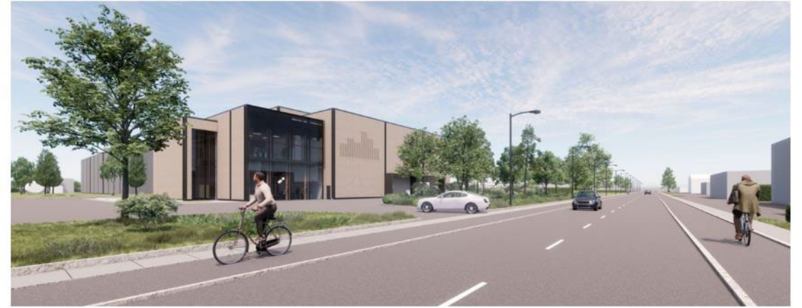
Visualisering af Værket ved Islev i Rødovre set fra Islevdalvej i retning mod Slotsherrensvej. Entreprenører: Ikke udbudt endnu
