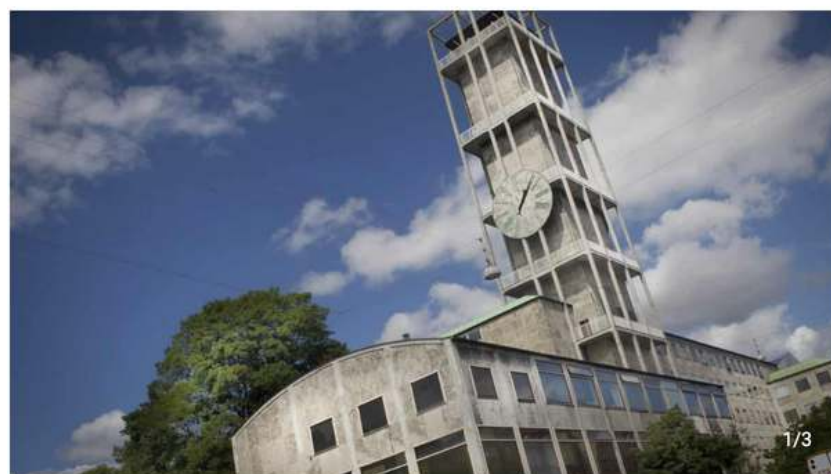
Drikkevandet på Aarhus Rådhus og fire andre kommunale bygninger er ramt af høje forekomster af legionella. Bakterien kan fremkalde alvorlig lungesygdom. Foto: Axel Schütt
