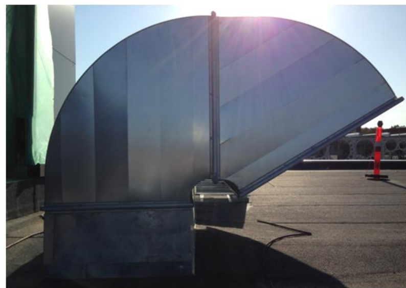
Tværsnitsarealet øges ud mod selve afkastet.
